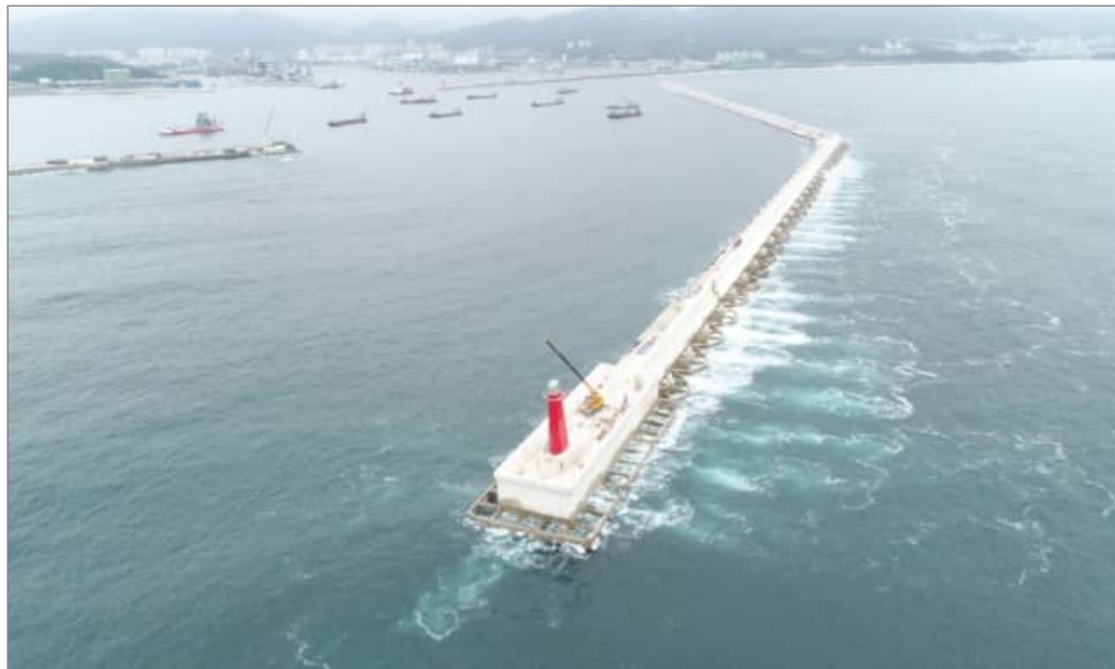
동해항 북방파제 수중공사 (2016.07~2020.02)
