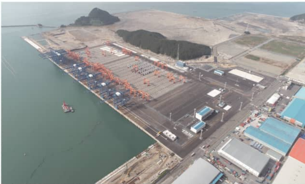
부산항신항 피더부두 건설공사중 수중 및 구조물공사 (2021.08.26~2024.06.12)
