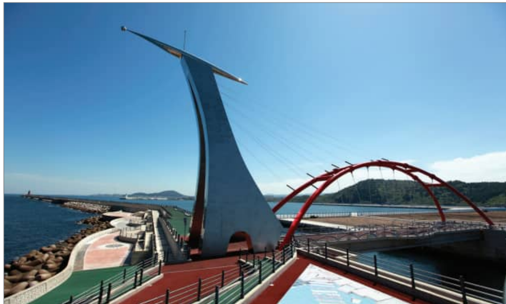
제주내항 · 외항 방파제 건설공사 (2002.07 ~ 2011.09)
