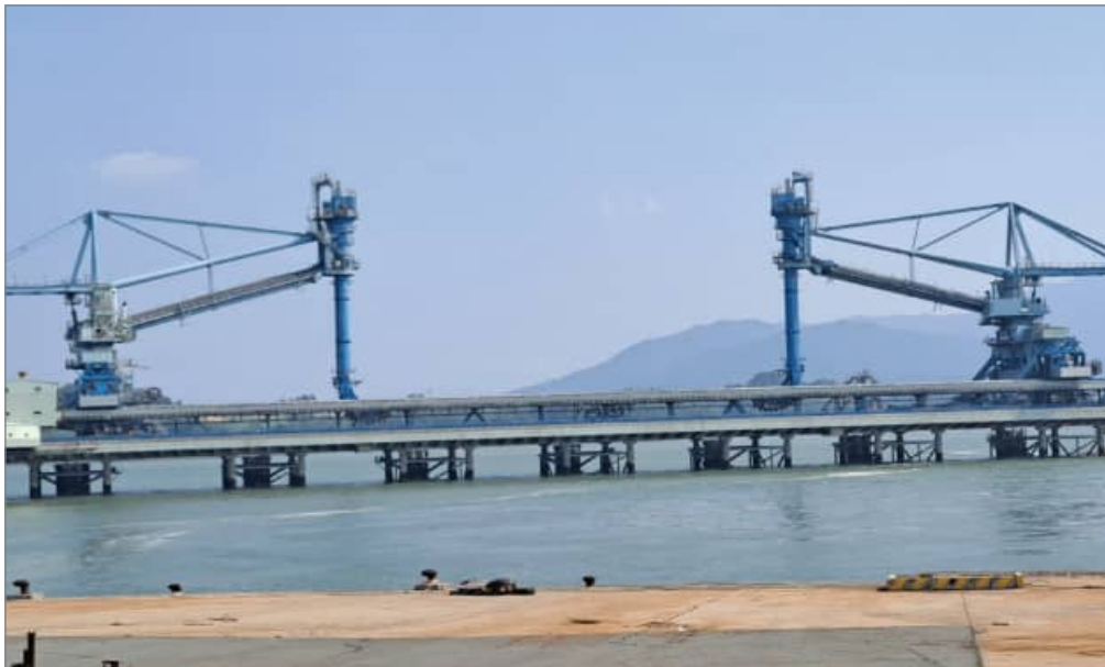
하동화력부두 접안능력 증대공사 (2020.03~2021.04)
