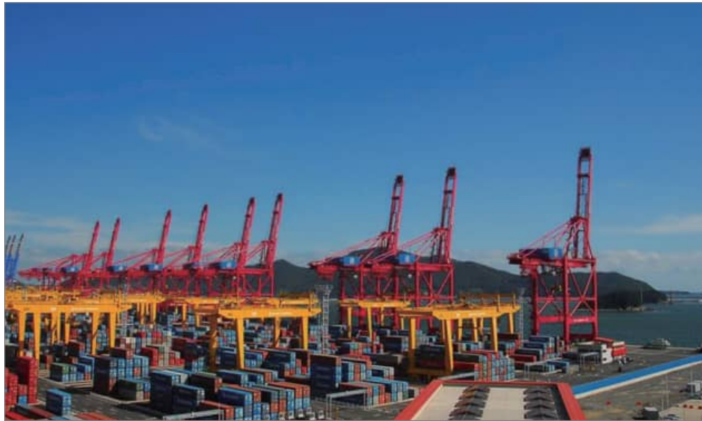
부산신항 남컨테이너부두 축조공사 (2005.11 ~ 2009.03)
