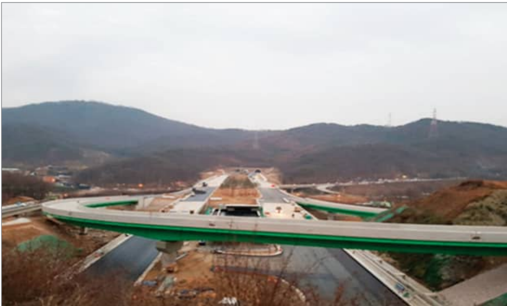
덕송~내각 고속화도로 조성공사 (2013.08~2017.04)
