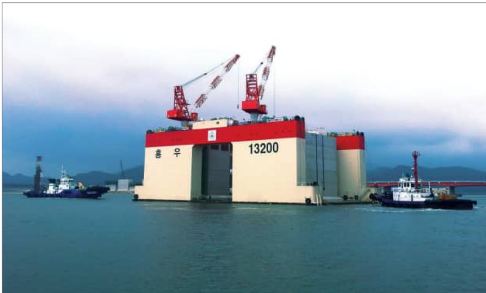
부산신항 서컨테이너터미널2-5단계 축조공사 (2013.03 ~ 2015.08)
