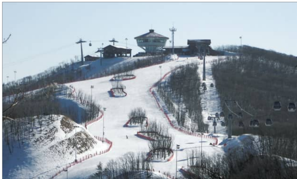
강원랜드 하이원 스키장 조성공사 (2004.05 ~ 2006.08)
